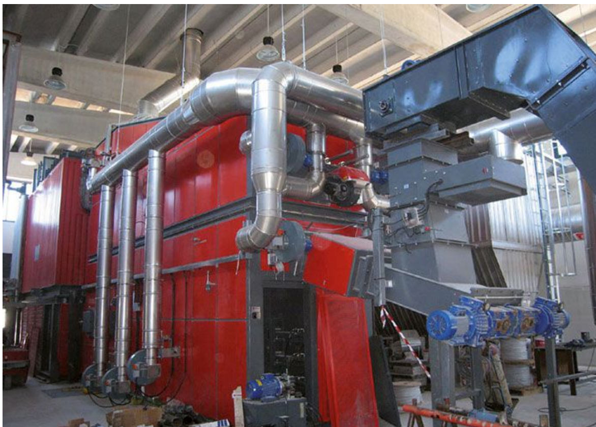
Εικόνα 18. Λέβητας Uniconfort εγκατεστημένος στο σταθμό παραγωγής ηλεκτρικής ενέργειας Fiusis (Ιταλία), ο οποίος καίει κλαδέματα από ελαιώνες για την παραγωγή CHP .
