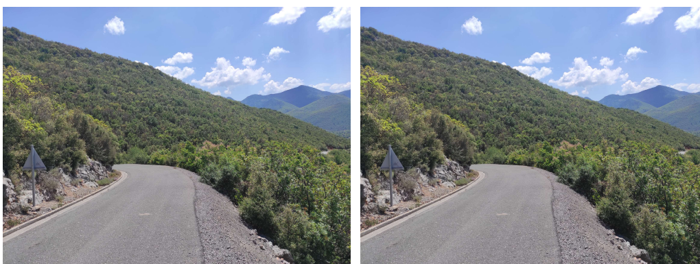
Εικόνα 4.11: Άποψη του οδικού δικτύου μεταξύ Άνω Αρφαρών και Πολιανής (αριστερά) και Άνω Αρφαρών και Πελεκητής (δεξιά).
